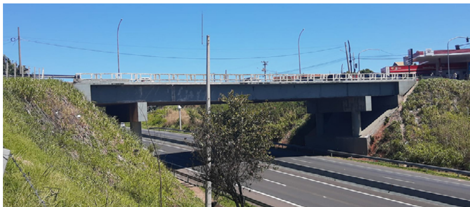
Alguns exemplos de passarelas em outros países e a viaduto da Vila Coimbra.
